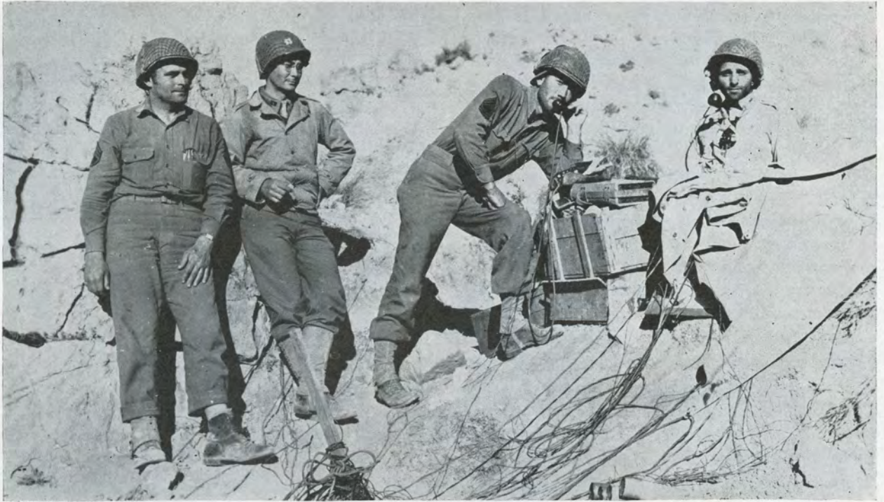
FALCON SWITCHBOARD . . . EL GUETTAR
